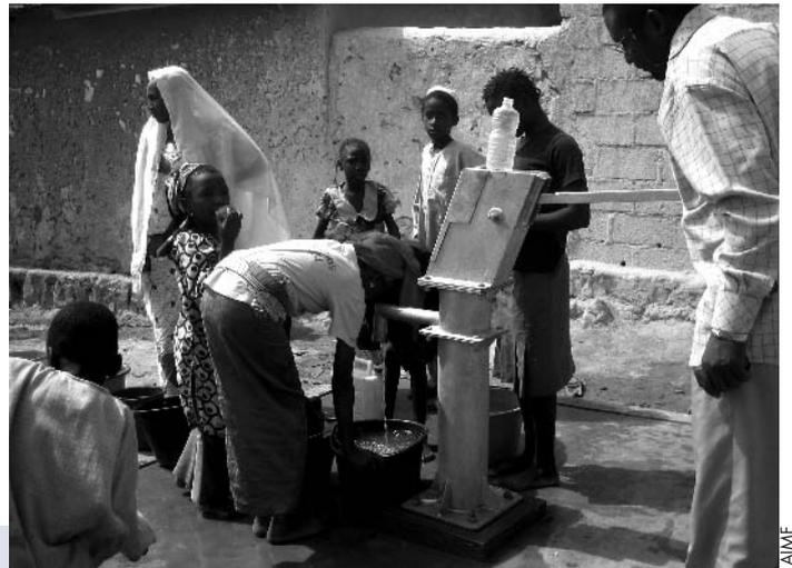
Les 10 forages réalisés, d'une profondeur de 47 et 60 m et d'un débit de 0,7 à 1 m<sup>3</sup>/heure, ont été équipés de pompes manuelles INDIA et de protections anti-bourbier.
